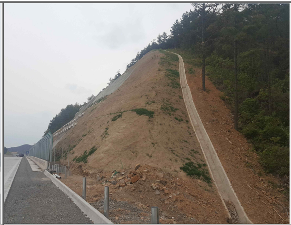
② 절토사면 시공 현황(중점 횡단)
