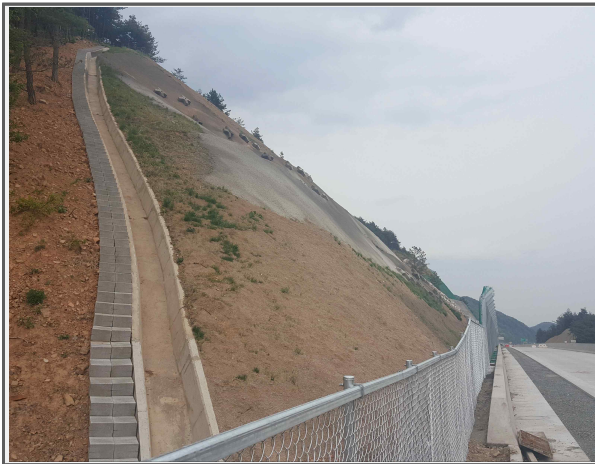
① 절토사면 시공 현황(시점 횡단)
